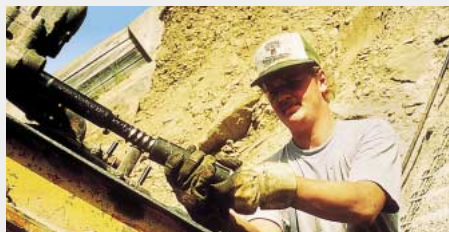
Montage du taillant
