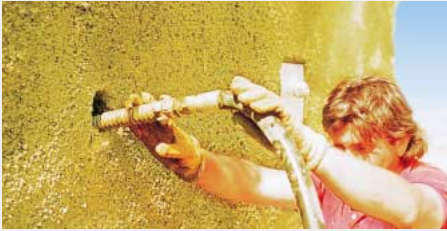
Injection à travers la barre creuse
