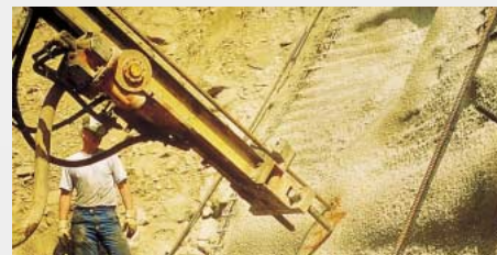
Travaux de forage
