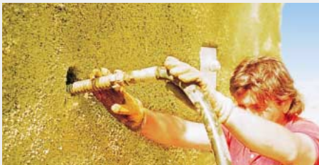
Injektálás az üreges horgonyrúdon keresztül
