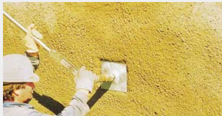
A horgony megfeszítése dinamométer- kulccsal vagy üreges feszítősajtóval
