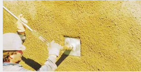
předpinání kotvy momentovým klíčem nebo napínacím zařízením
