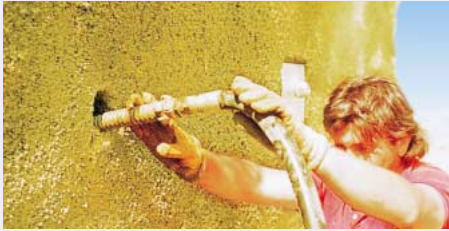
injektáž dutou tyčí
